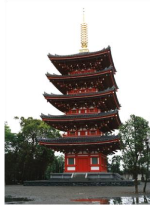
「500年コンクリート（写真2）」
